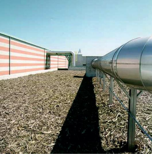
■ *Biofilter reinigen pro Stunde 100.000 Kubikmeter Abluft aus Biogasanlage und Kompostierung. Eine Geruchsbelästigung in der Umgebung ist daher fast ausgeschlossen.*
