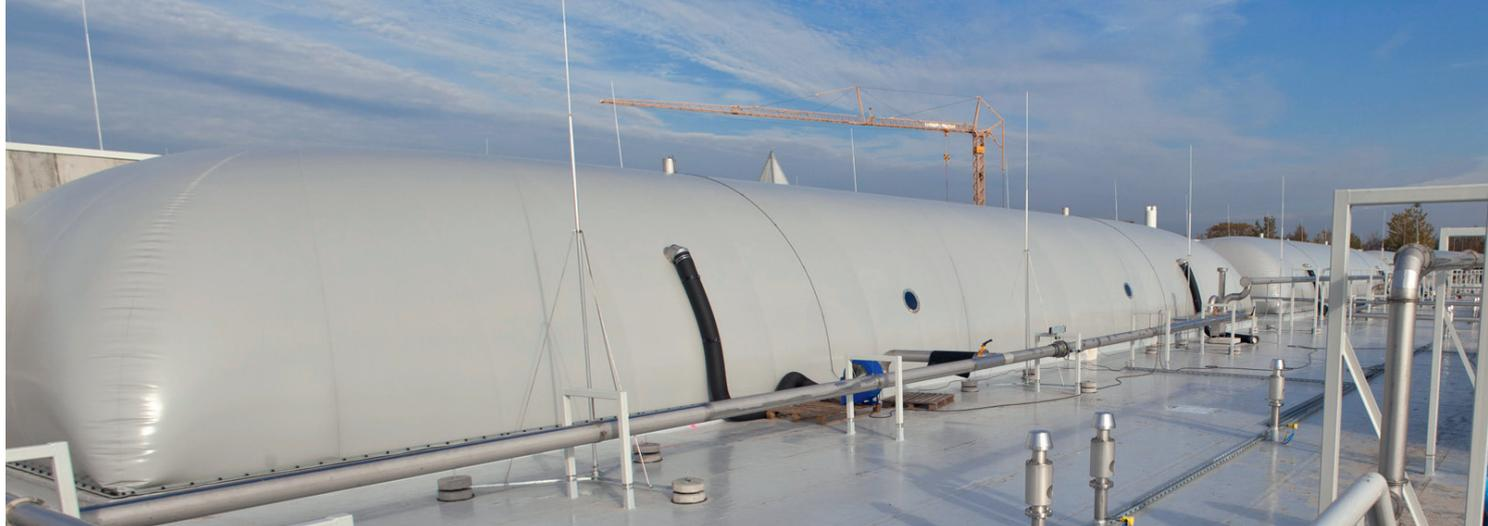
■ *Futuristischer Anblick: Drei Gasspeicher auf dem Dach der Biogasanlage fangen das Methan aus den 21 Fermentern auf. Anschließend wird das Gas gereinigt und als Bio-Methan ins Netz eingespeist.*
