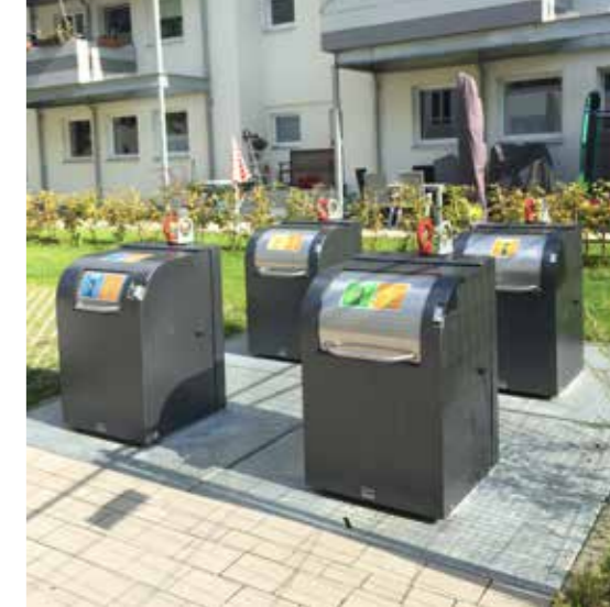
■ Die Stadtreinigung Hamburg bietet eine zeitgemäße Abfallentsorgung über Untersflurssysteme.
