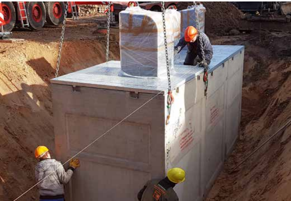
■ Einbau von Betonschächten für Unterflursystembehälter (UFS).
